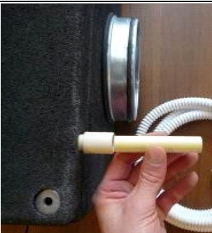
Tiesaus kondensato nuvedimo vamzdelio prijungimas su linijos prijungimo įvare
