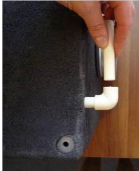
Kondensato nuvedimo vamzdelio prijungimas su 90° alkūne ir linijos prijungimas
