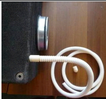
Linijos įstatymas ir pritvirtinimas gnybtu (gnybtą ir liniją pristato santechnikos montavimo įmonė)
