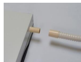
Kondensato nupylimo vamzdelio atjungimas nuo įrenginio
