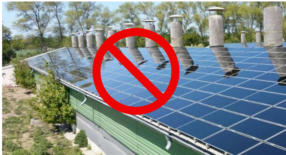
Sankaupos ant stiklinių paviršių dėl netoliese esančių kaminų 6
