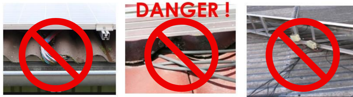
Netinkamo kabelių įrengimo pavyzdys 13
